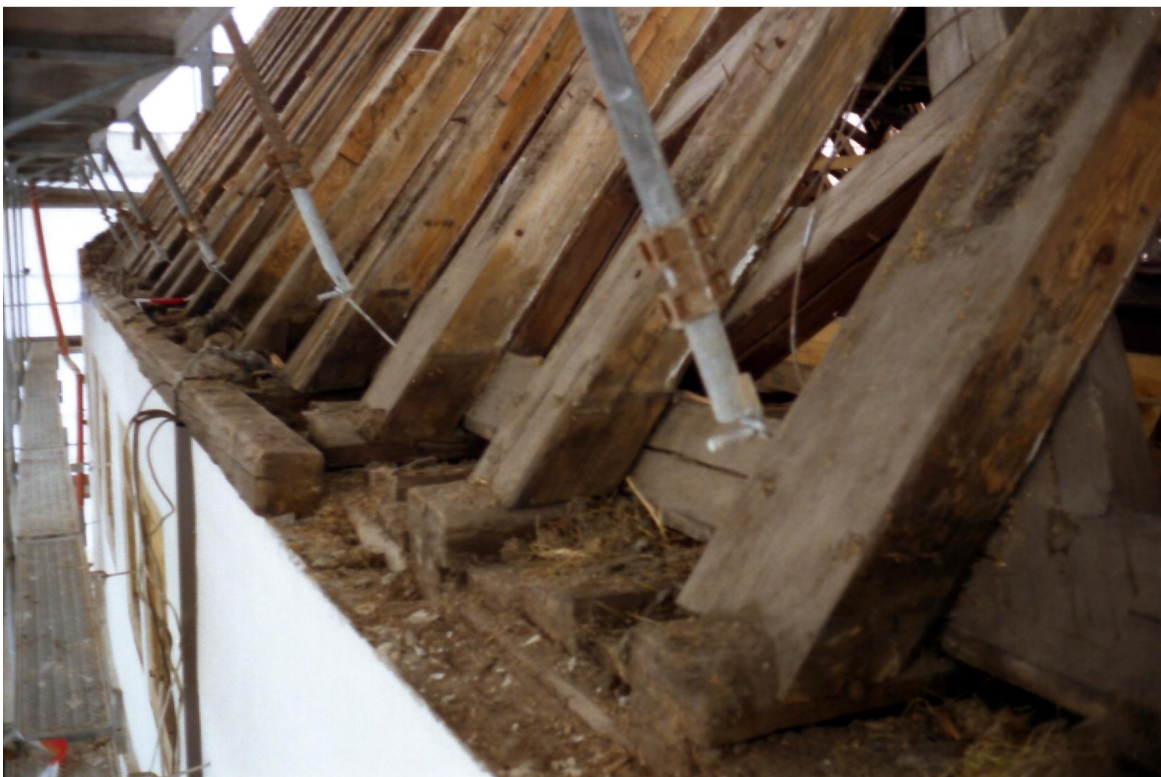
TRAUFE DACHSTUHL NACH DER FREILEGUNG
