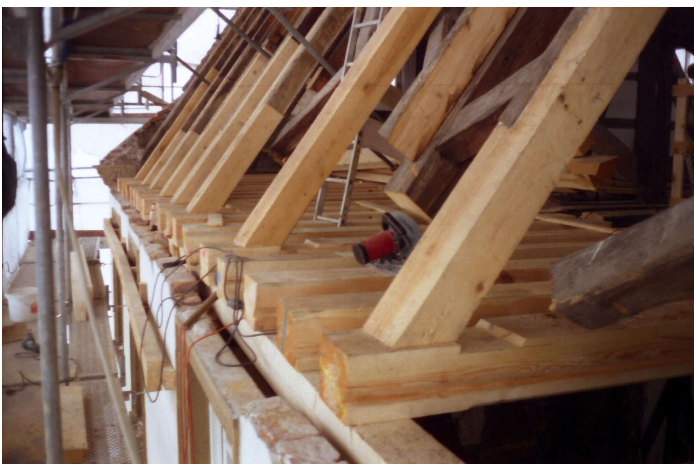
TRAUFE DACHSTUHL WÄHREND DER REPARATURARBEITEN
