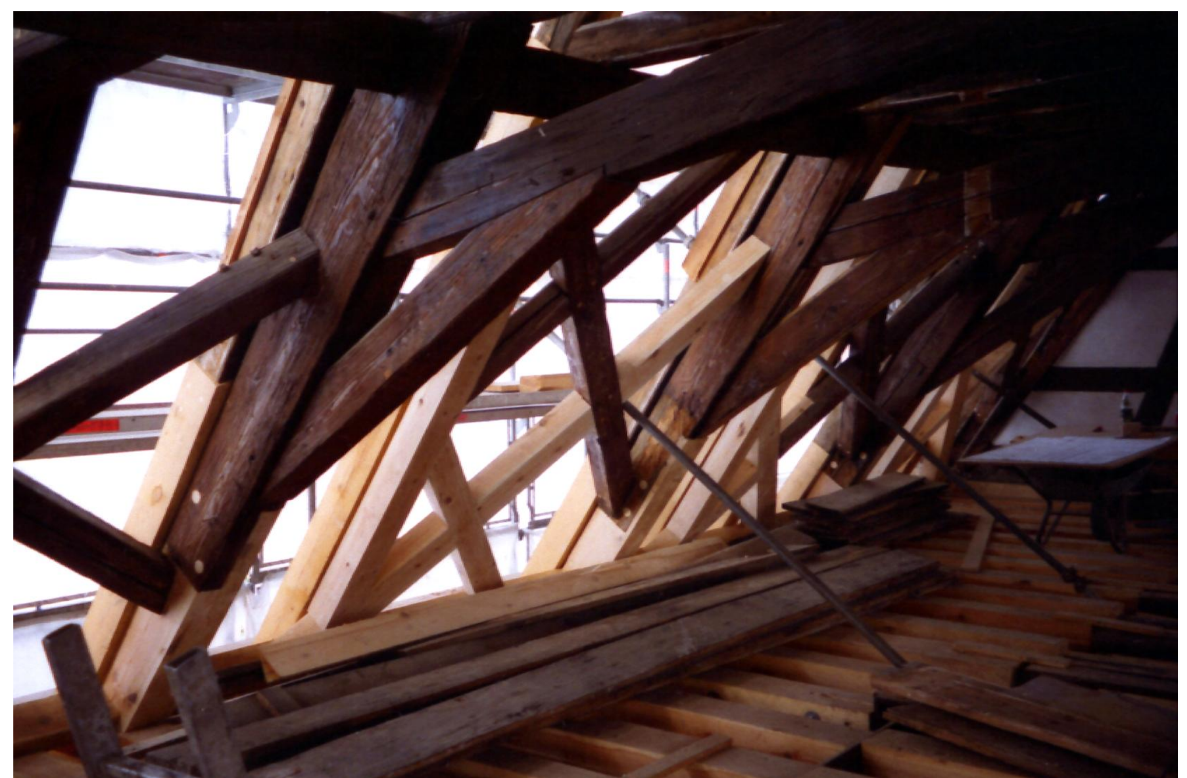
1. DAGHGESCHOSS NACH REPARATUR DER ANDREASKREUZE
