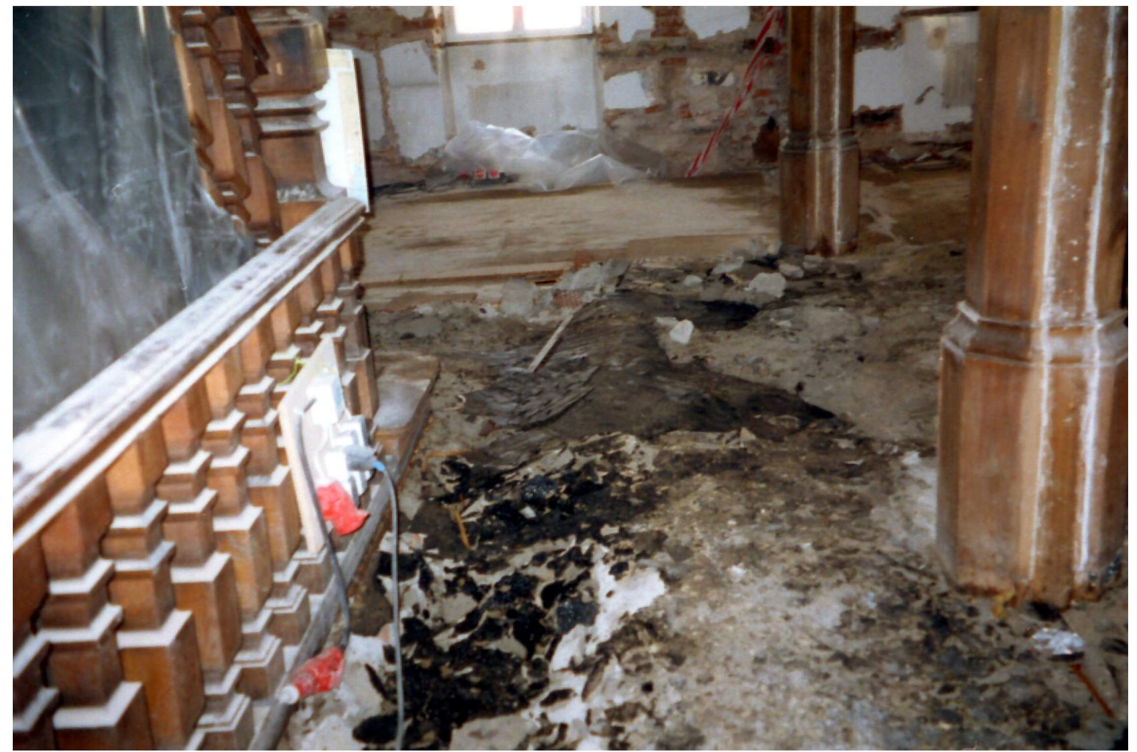
AUSBAU DER PAK-HALTIGEN BÖDEN
