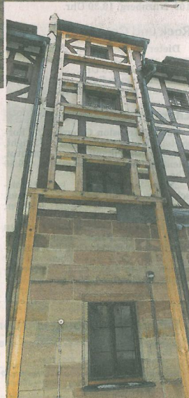
Das mächtige Pilatushaus am Tiergärtnerplatz ist eine wichtige Sehenswürdigkeit der Stadt. Architekten ließen nun die Rückwand (kleines Foto) mit Holzstreben sichern. Fotos: Distler
